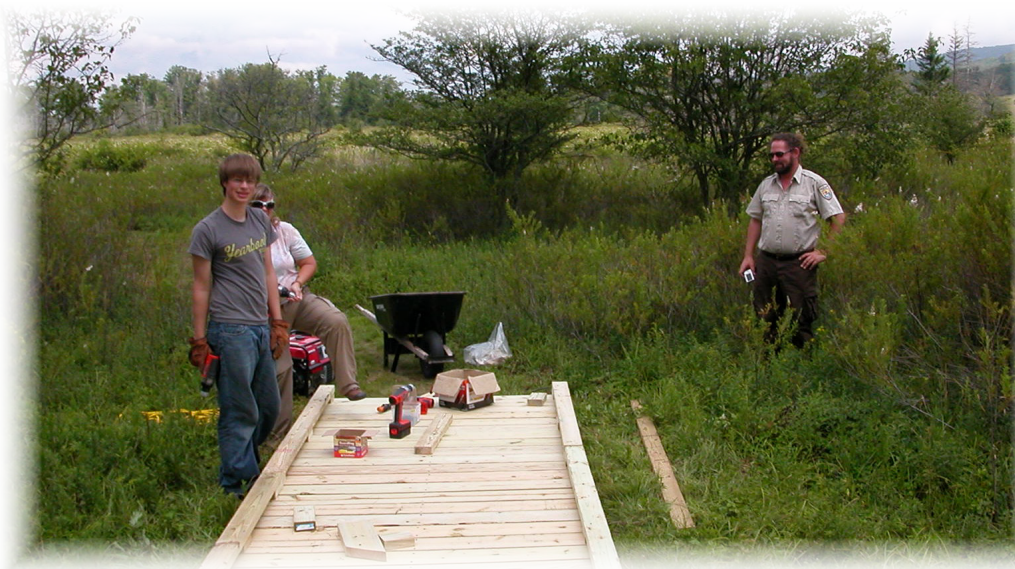
Un grupo de voluntarios construye un camino elevado en un sendero universalmente accesible en el Refugio Nacional de Vida Silvestre de Canaan Valley (WV).
